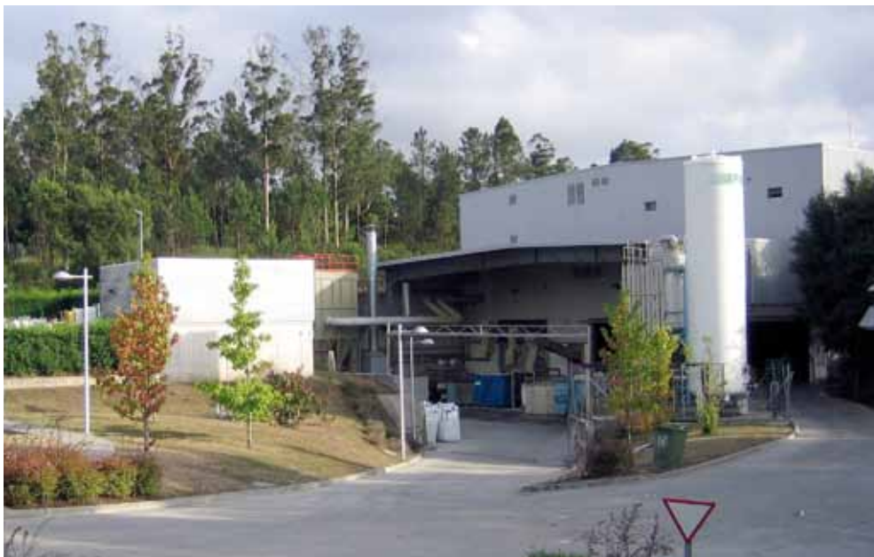
Planta de Tratamiento de Residuos Voluminosos de Galicia.
